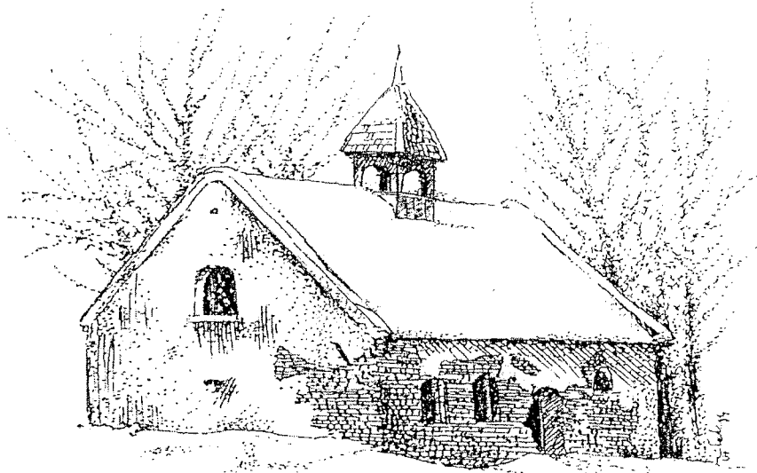
KAPELLE AUS DEM 18. JH. IN MIRACHOWO (VOR DER RENOVIERUNG)
